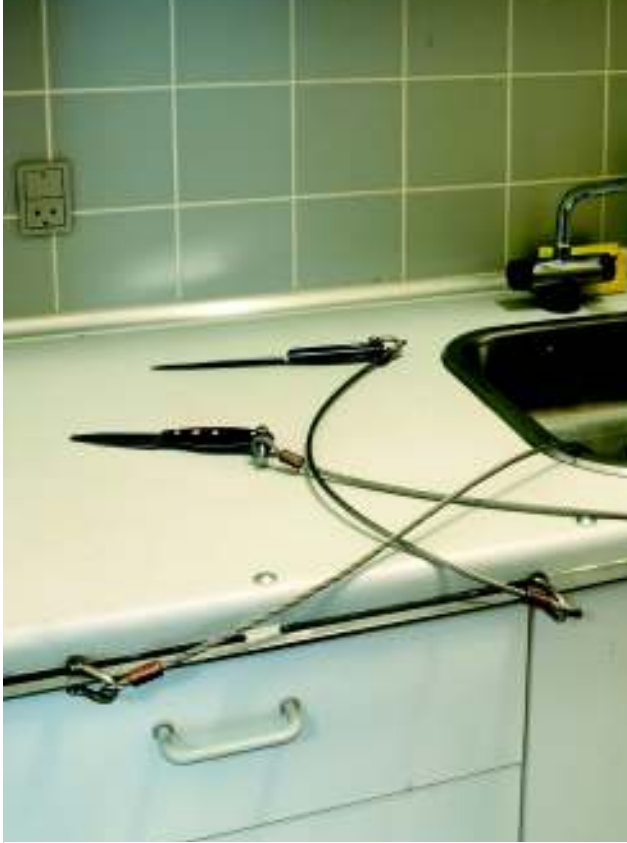
Knivene i de indsattes thékøkken er fastgjort til en stålstang med stålwirer.
