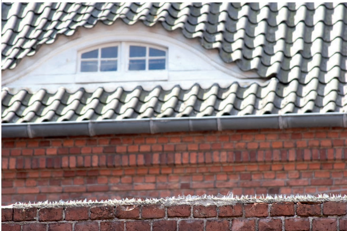
Murkronen er sikret med indstøbte glasskår.
