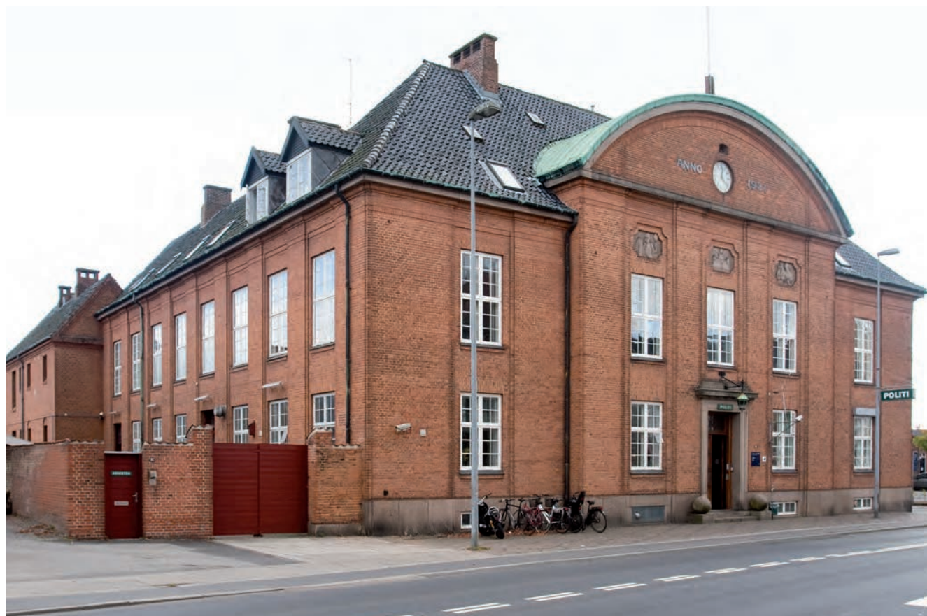
Tinghuset med arresthuset bagved.
