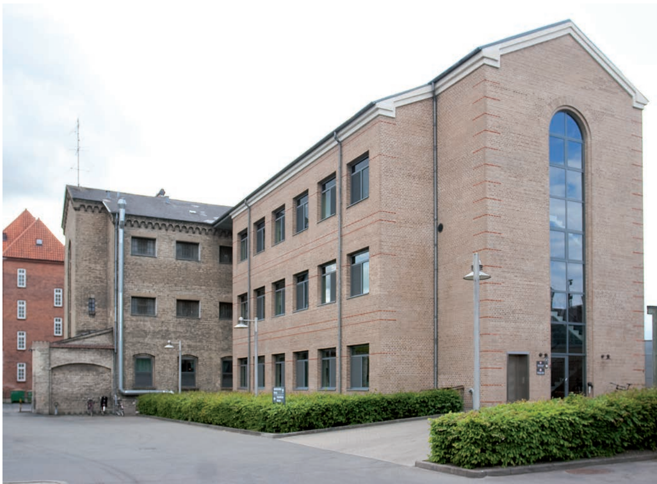
Den nye fløj blev opført i 1999 med værksteder, personaleomklædning, administration, besøgsfaciliteter og 12 celler med eget toilet og bad. Den nye fløj er tegnet af Alex Poulsen Arkitektkontor. I baggrunden ses den gamle panoptiske arrest fra 1861, tegnet af N.S. Nebelong.
