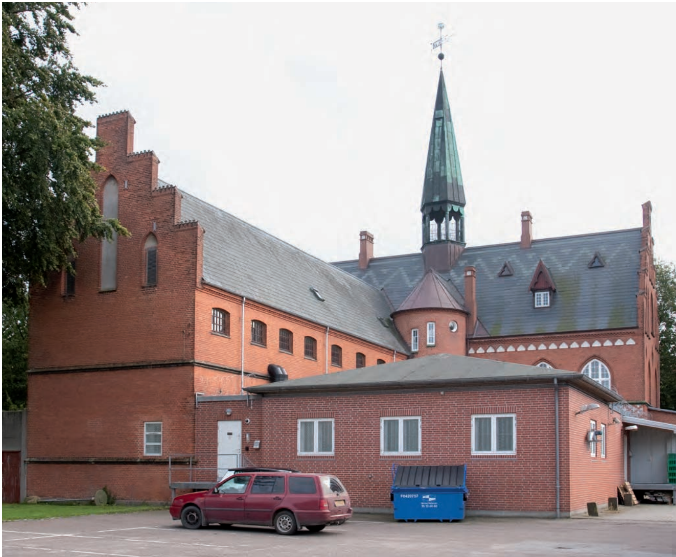
Arresten på bagsiden af tinghuset blev opført i 1891, mens tinghuset blev opført i 1893.
