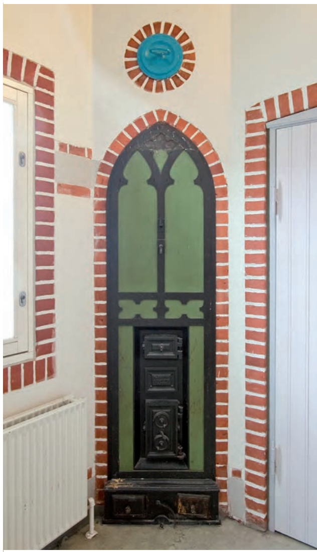
Cellegang med indmuret ovn.
