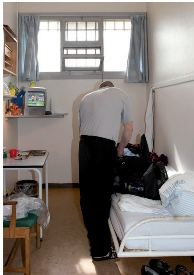
Selvom vinduet er i hele cellens bredde, sidder det stadig højt, der er armatur (tremmer), og sengen kan låses op mod væggen, selvom byggeriet er fra 1969.
