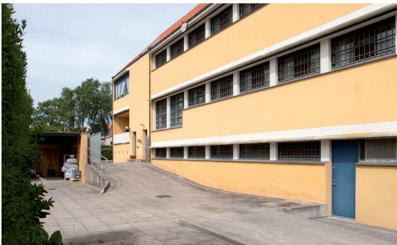
Vestfacade med kældervinduer til værksteder og cellevinduer i 1. og 2. etage. Længst borte den tidligere arrestforvarerbolig, der nu er indrettet til kontorer og overnatningskvarter til personale, der gør døgntjeneste.
