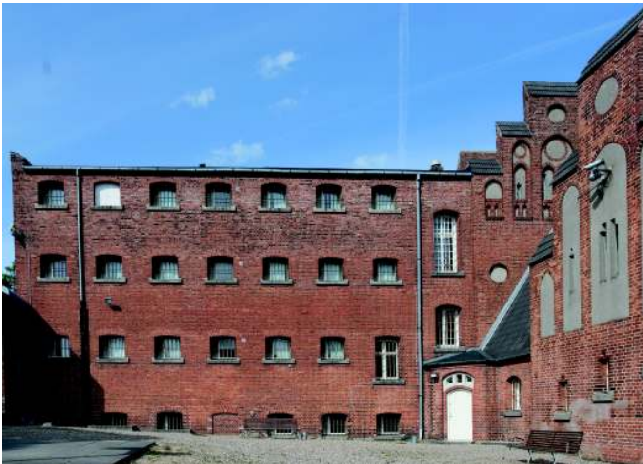
Sydvestfacaden i cellefløjen opført i 1905.
